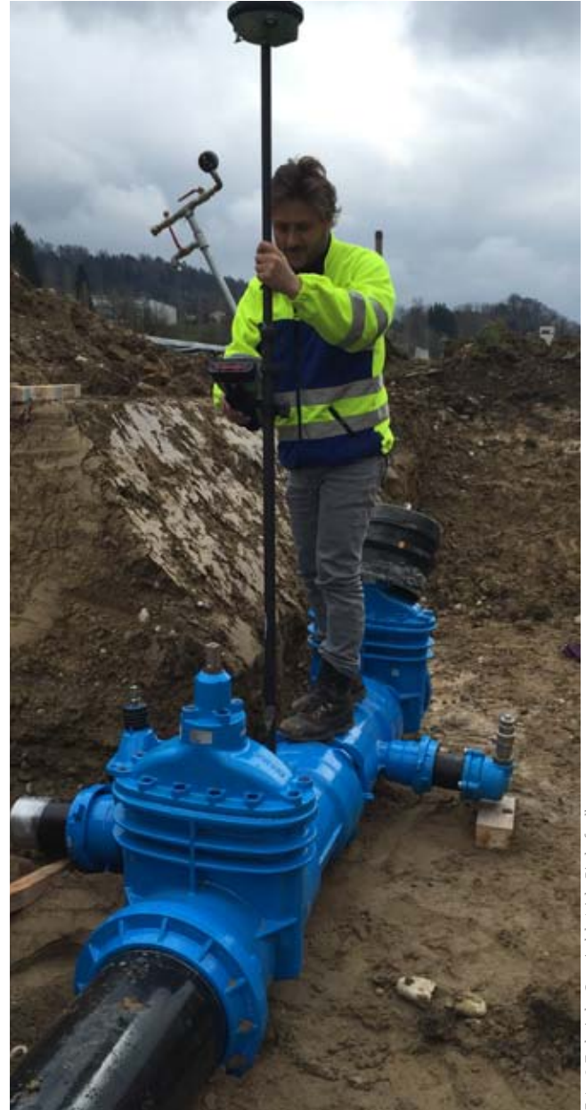
Vermessungsleistungen von Leitungserweiterungen werden teilweise vom Zweckverband Mühlbach selbst durchgeführt, teilweise vergeben. Für die Datenpflege und die Netzkontrolle hinsichtlich Datenqualität unterstützt axmann geoinformation den Wasserverband.
